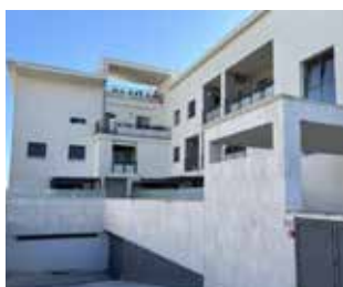
Via Santa Rita. Le finiture e i livelli di impianto sono caratteristiche della
